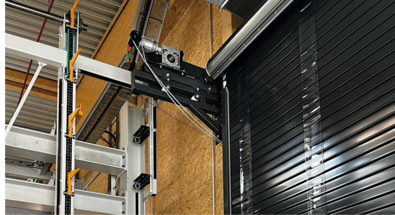
Das Torblatt besteht aus doppelwandigen Aluminium-Lamellen mit einem mehrschichtigen ISO-Kern. Eine dreiseitig geschlossene Einbruchschutz-Laufschiene sorgt für einen Rund-Um-Eingriff-Schutz. Damit wird Ihr Geschäftsbereich durch einen einbruchssicheren Rolltorpanzer effektiv und zuverlässig geschützt. Auf Wunsch sind verschiedene Zusatzoptionen erhältlich.
